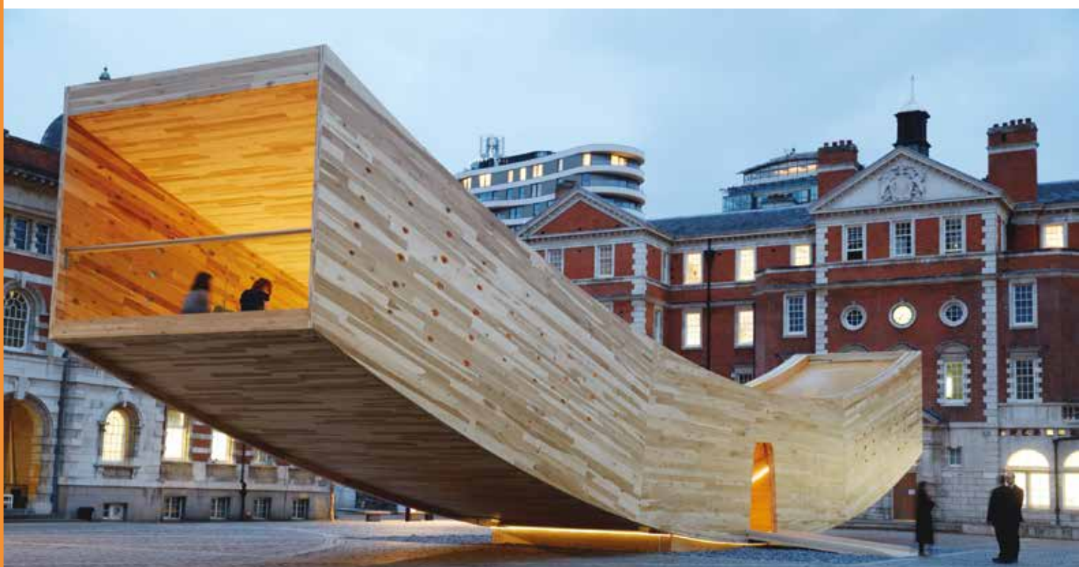
Dự án The Smile của Alison Brooks Architects và Arup trong Lễ Hội Thiết Kế London 2016
