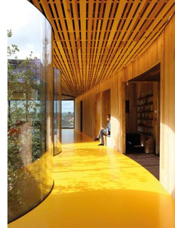
Esta peça pioneira de arquitetura permanente é construída a partir de mais de 20 painéis de tulipeiro americano laminado cruzado de cinco camadas, variando em tamanho de 0,5 m - 12 m de comprimento. O centro eleva-se sobre de armações de aço de 4m calçadas em blocos de concreto dentro do terreno do Royal Oldham Hospital. Seu jardim situa-se em um declive e a vista panorâmica permite enxergar até os Pennines.
