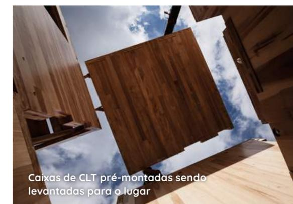
Caixas de CLT pré-montadas sendo levantadas para o lugar
